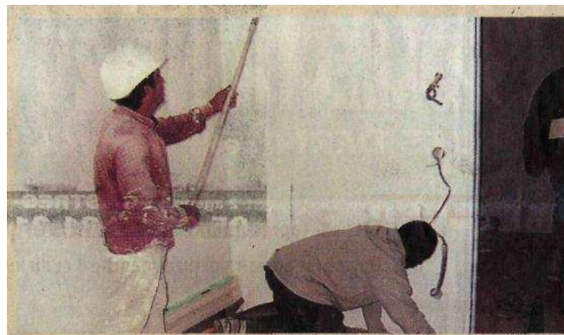
Le chantier est désormais centré sur le second œuvre
