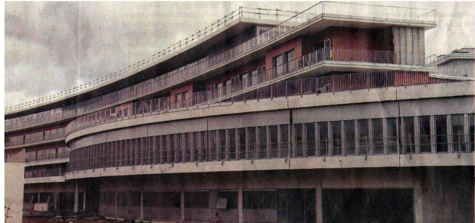
L'essentiel du chantier sera achevé en mai pour une ouverture prévue à la rentrée de septembre 2010. Photo DDM, Thierry Antoine
